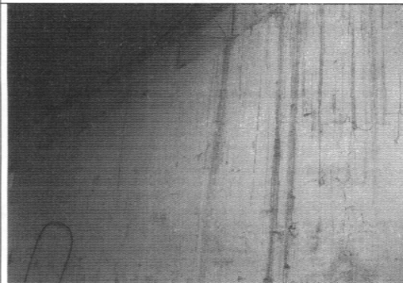
Foto 5. Muros bodega en buen estado
