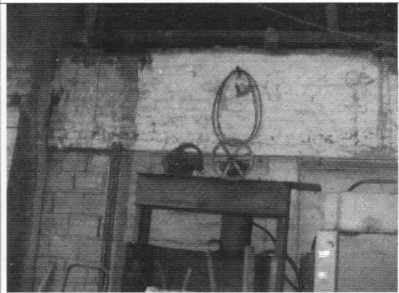
Foto 4. Muros internos bodega
