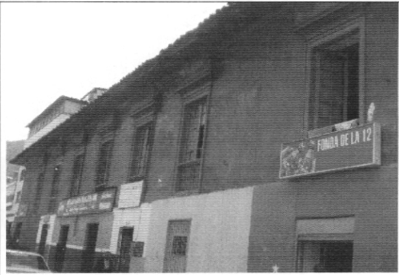
Foto 2. Fachada costado norte
