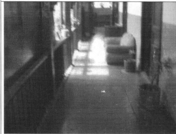
Foto 9. Entrepiso en madera en buenas condiciones
