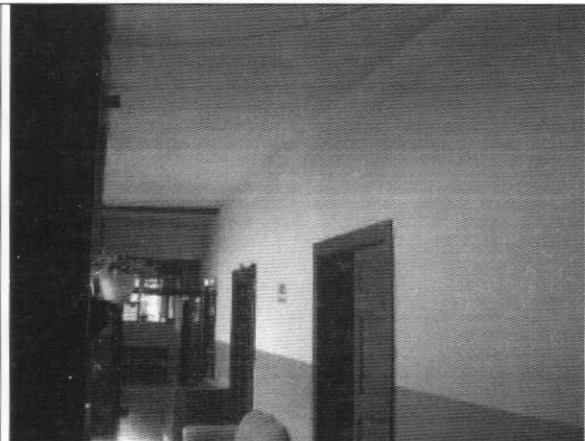
Foto 8. Muros de segundo piso en buen estado
