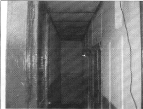
Foto 7. Muros segundo piso
