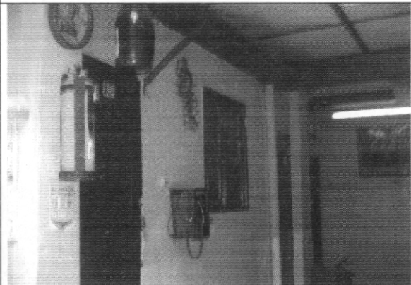
Foto 6. Muros primer piso
