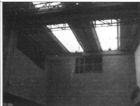
Foto 6. Cubierta bodega costado norte
