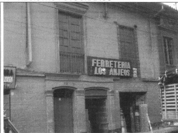
Foto 1. Aspecto general de la fachada
