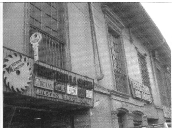
Foto 2. Aleros y muros de fachada en buen estado
