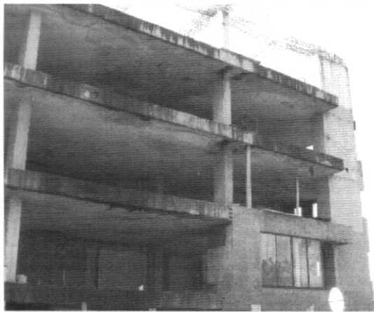
Foto 3. Fachada costado norte
