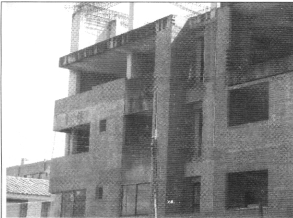
Foto 1. Aspecto general de la fachada, costado occidental
