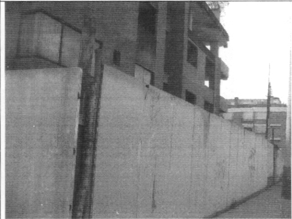
Foto 6. Cerramiento costado occidental
