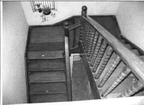
Foto 14. Escalera de madera en buen estado
