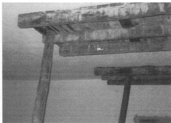
Foto 3. Placa de entepiso en buen estado
