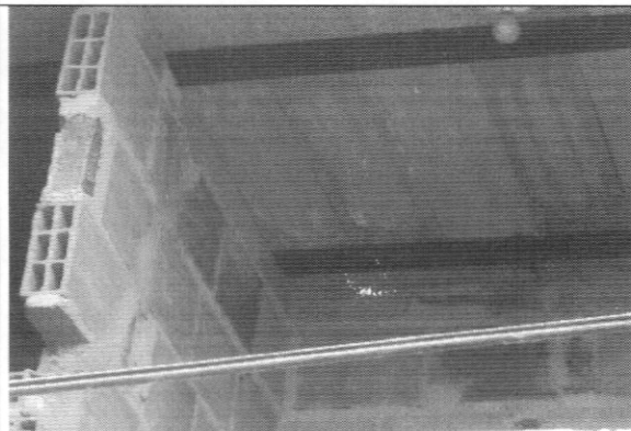
Foto 5. Muros segundo nivel
