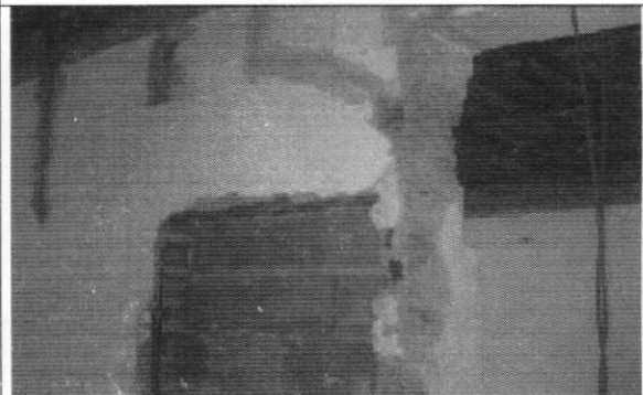
Foto 6. Demolición parcial de muros portantes
