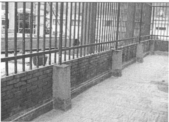
Foto 9. Impermeabilización de terraza y antepecho costado norte
