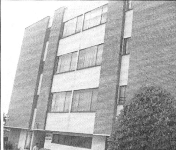
Foto 1. Vista general de la fachada del inmueble
