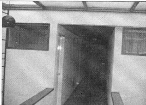
Foto 7. Muros cuarto piso
