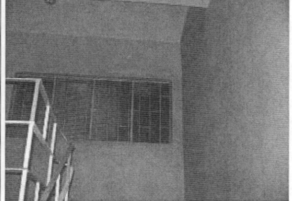
Foto 4. Muros internos en buen estado
