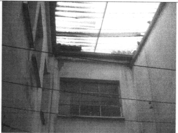
Foto 10. Apoyo de cubierta en buen estado.
