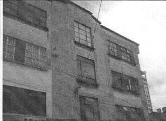
Foto 1. Fachada principal de la edificación
