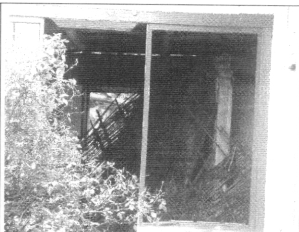
Foto 8. Colapso cielo raso, costado sur
