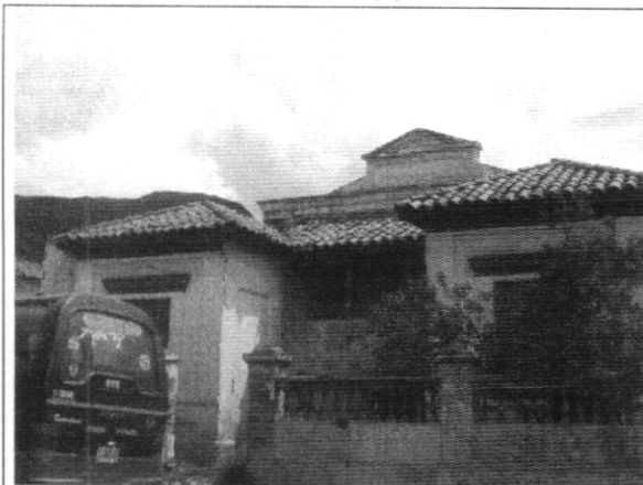
Foto 1. Fachada principal de la edificación
