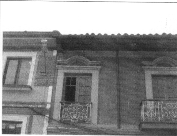
Foto 3. Muros fachada, segundo piso
