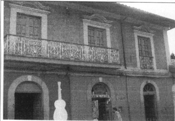
Foto 1. Muros de fachada
