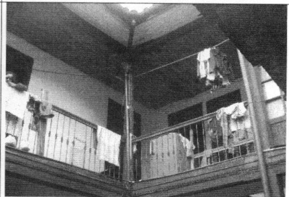
Foto 6. Aspecto general de muros del segundo piso
