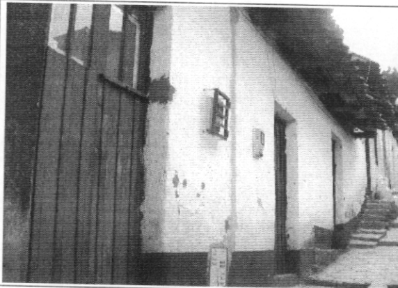
Foto 3. Muros interiores costado norte, zona frontal
