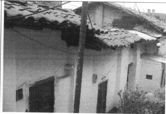
Foto 4. Muros interiores costado sur, zona frontal
