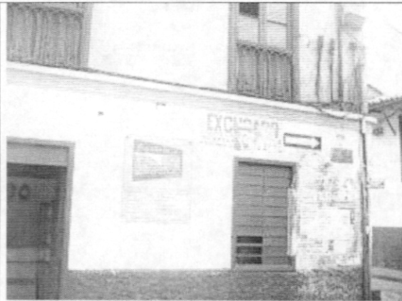
Foto 1. Muros de fachada primer piso costado occidental
