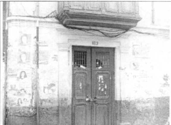
Foto 2. Muros de fachada primer piso costado sur
