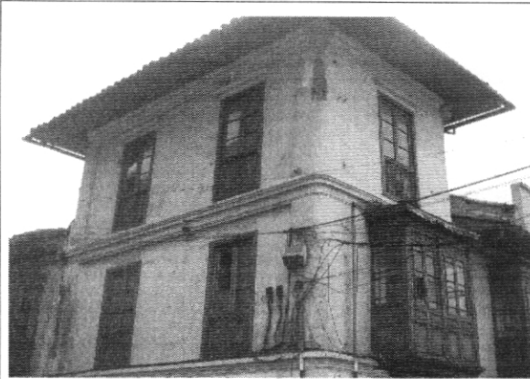
Foto 3. Muros de fachada segundo y tercer piso.
