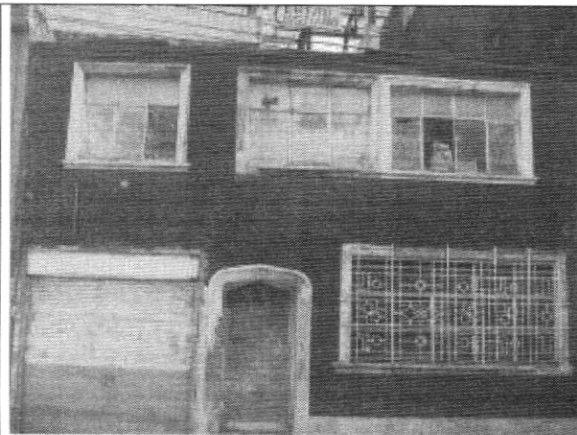
Foto 1. Vista general del muro de cerramiento
