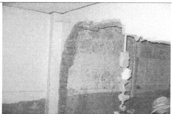
Foto 6. Demolición parcial de muros de primer piso
