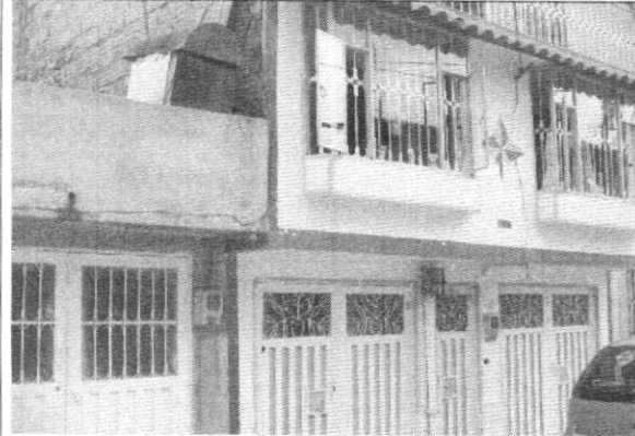
Foto 1. Vista general del inmueble
