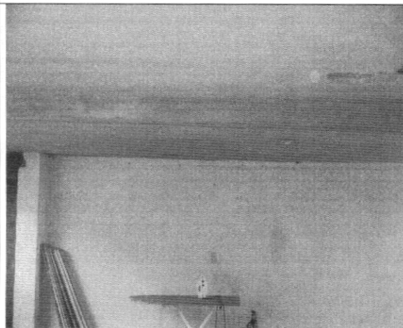
Foto 5. Placa de entrepiso, buenas condiciones
