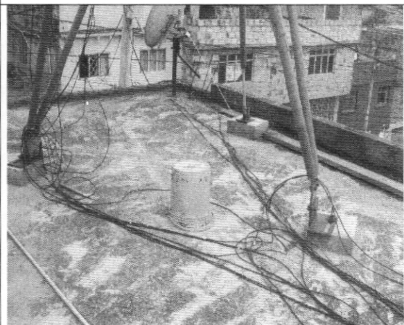
Foto 6. Apoyo de antena parabólica en placa de cubierta
