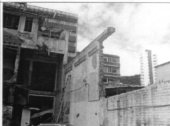
Foto 8. Fragmento de viga del muro demolido
