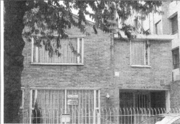
Foto 1. Vista general del inmueble
