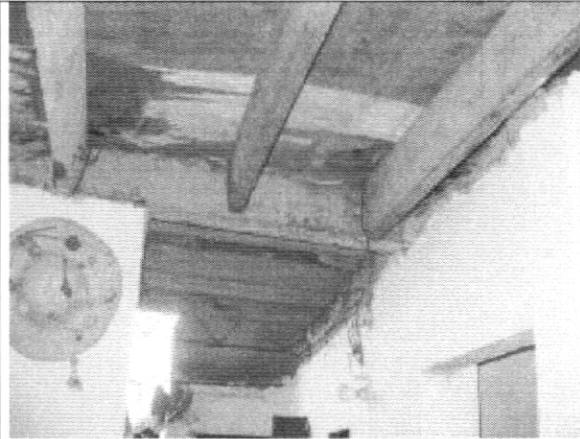
Foto 4. Entrepiso de madera
