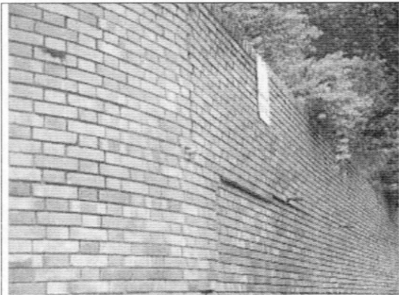
Foto 1. Vista general del muro
