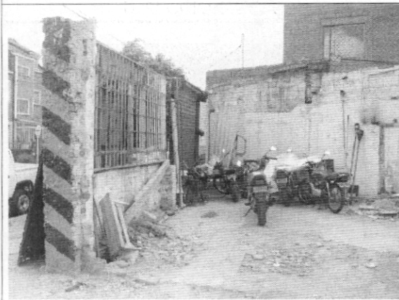
Foto 5. Extremo norte del muro del costado occidental, se han dejado la ventana y la puerta
