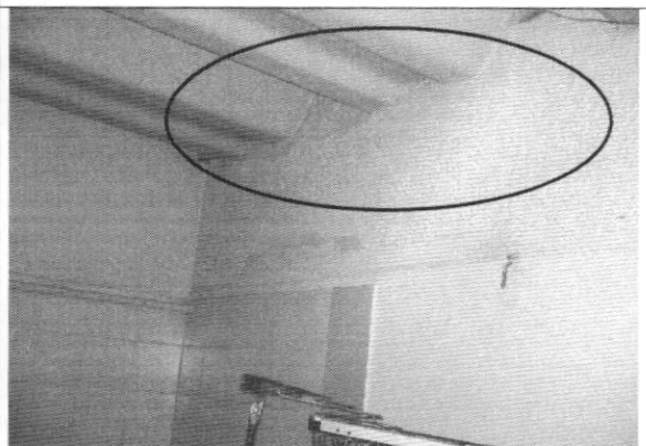
Foto 8. Tejas fisuradas en costado occidental, local central
