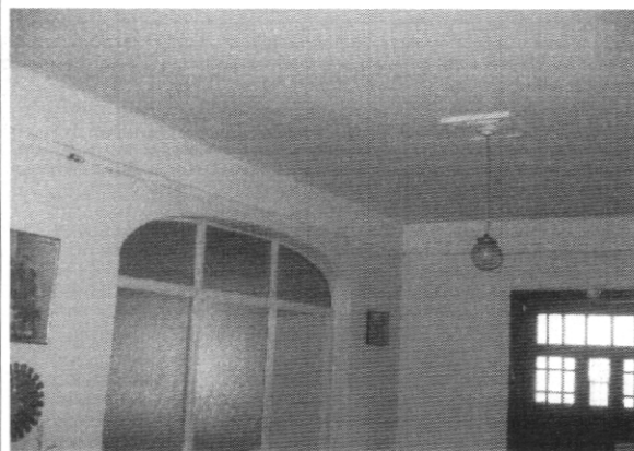
Foto 3. Muros primer piso
