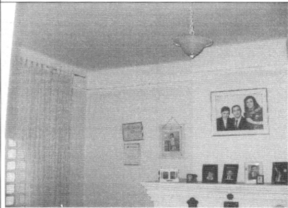
Foto 4. Muros y entepiso en buenas condiciones
