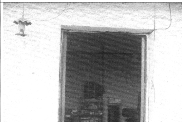
Foto 6. Muros zona terraza en buenas condiciones
