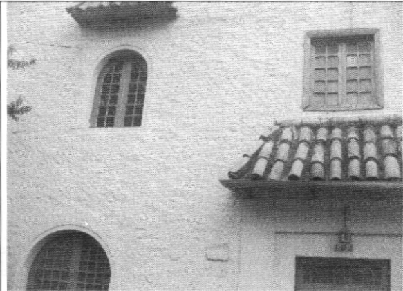
Foto 2. Muros de fachada en buen estado
