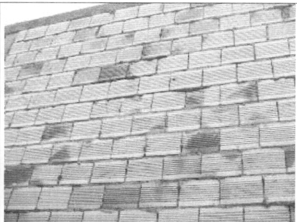
Foto 2. Paño del muro en buen estado
