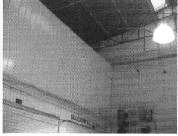
Foto 4. Estructura metálica, bodegaje sobre locales
