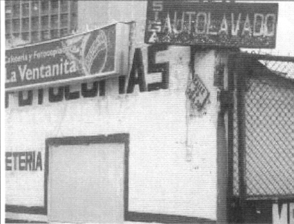
Foto 1. Muro cerramiento costado sur
