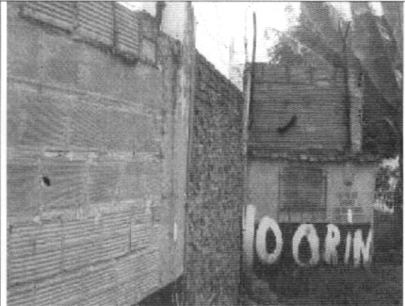
Foto 2. Muro cerramiento costado oriental, extremo sur
