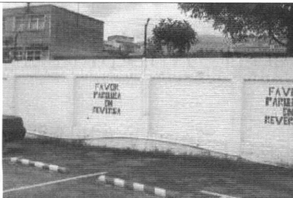
Foto 5. Muro de cerramiento, vista cara interior
