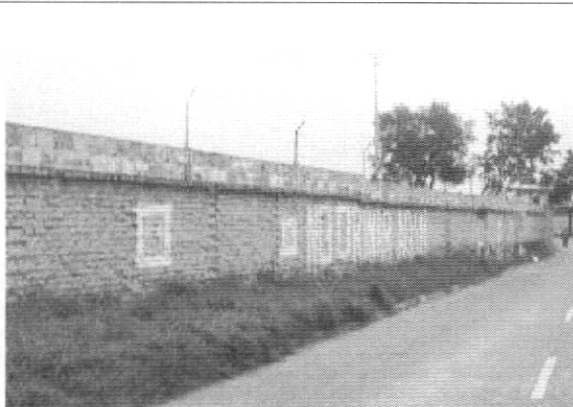
Foto 3. Muro de cerramiento costado oriental
