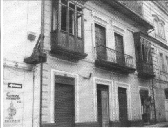
Foto 1. Vista general del inmueble.
