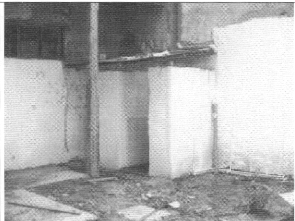
Foto 8. Bateria de baños en zona posterior
