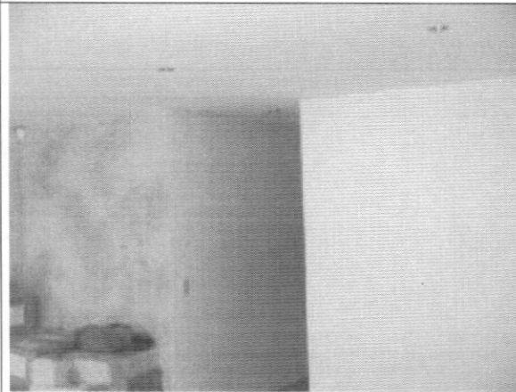
Foto 5. Muros y placa de segundo piso.
