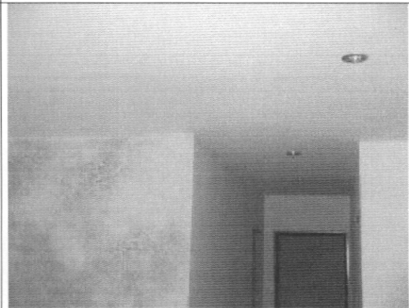
Foto 6. Muros y placa de tercer piso.
