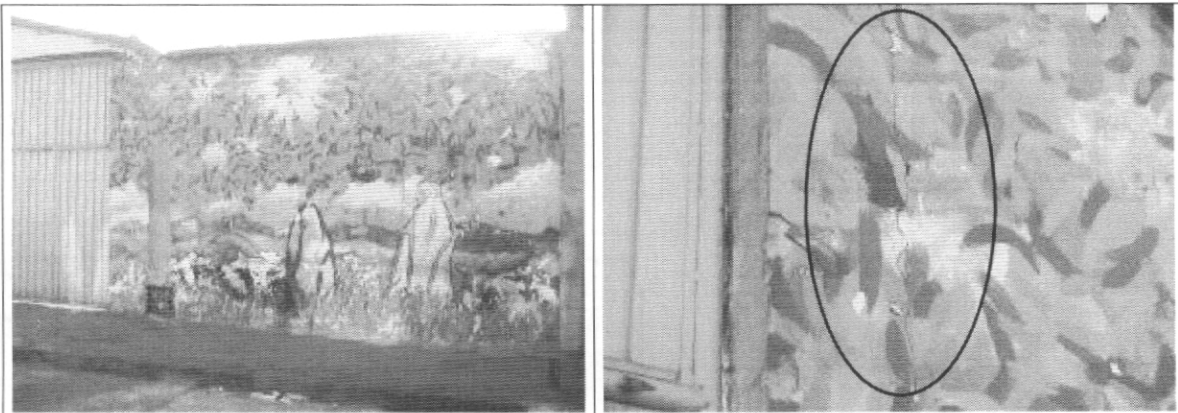
Foto 1. Vista muro de cerramiento
