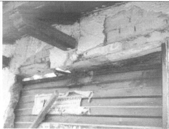
Foto 5. Desprendimiento de unidades en muro sobre vano de ventana
