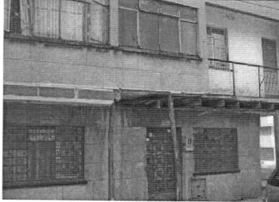
Foto 1. Fachada del inmueble, costado occidental.
