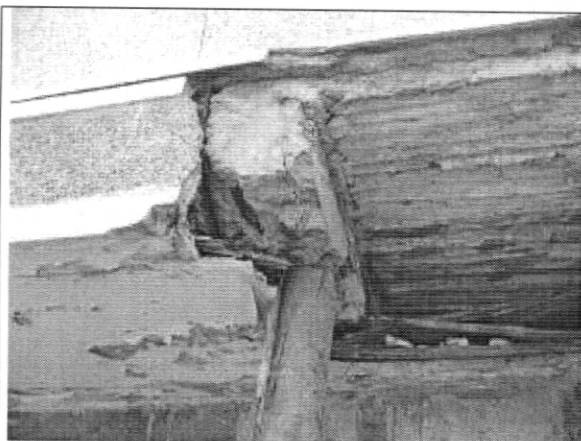
Foto 7. Viga de voladizo fracturada.
