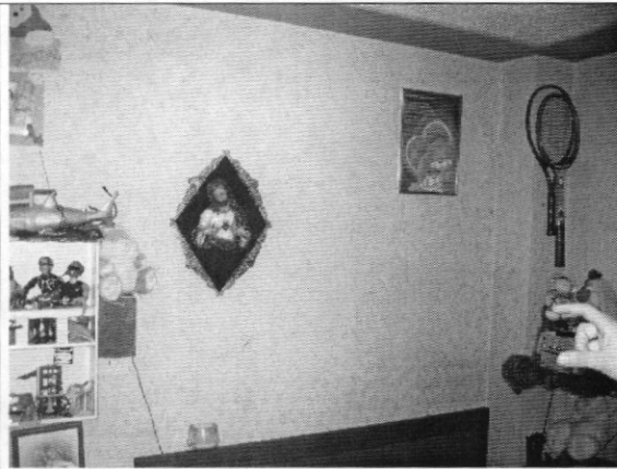
Foto 3. Aspecto interno del segundo piso sin daños
