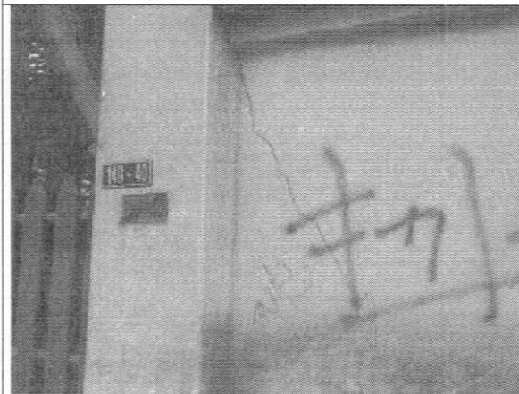
Foto 5. Grietas parte superior, costado norte.
