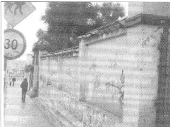
Foto 1. Aspecto general del muro de cerramiento, cara exterior.
