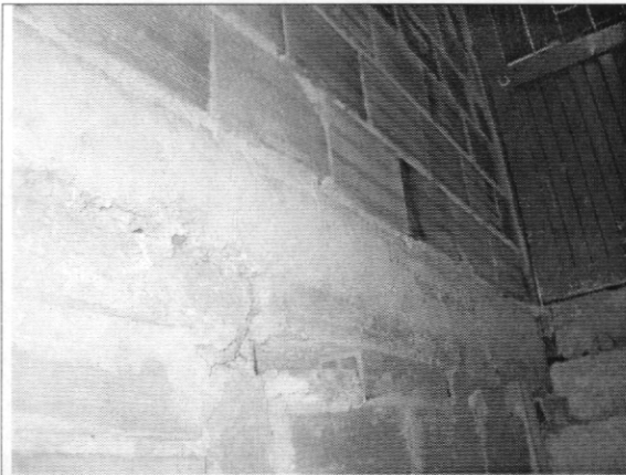
Foto 3. Muros internos de primer piso
