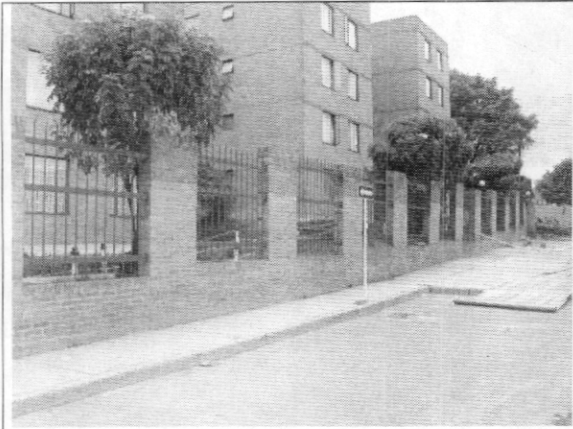
Foto 1. Aspecto general del muro
