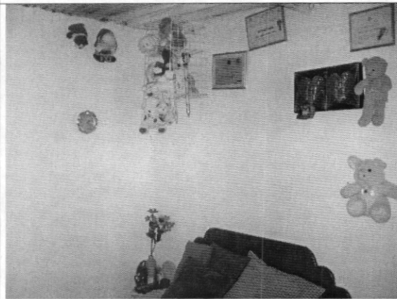
Foto 3. Muros internos de segundo piso
