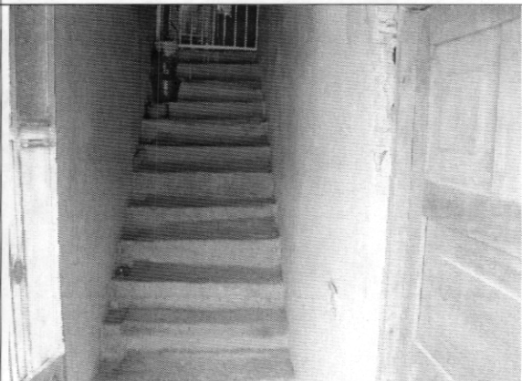
Foto 6. Escalera sin daños evidentes
