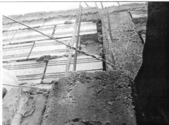
Foto 5. Prolongación de aceros de refuerzo de la columna
