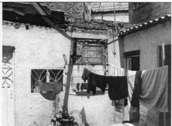
Foto 10. Muros del patio sin daño
