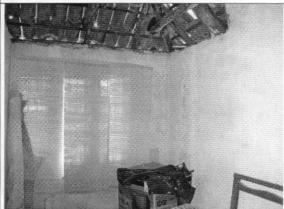
Foto 4. Muros de segundo piso no se detectan daños
