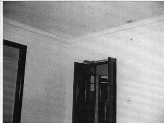
Foto 8. Cielo rasos y muros en buen estado
