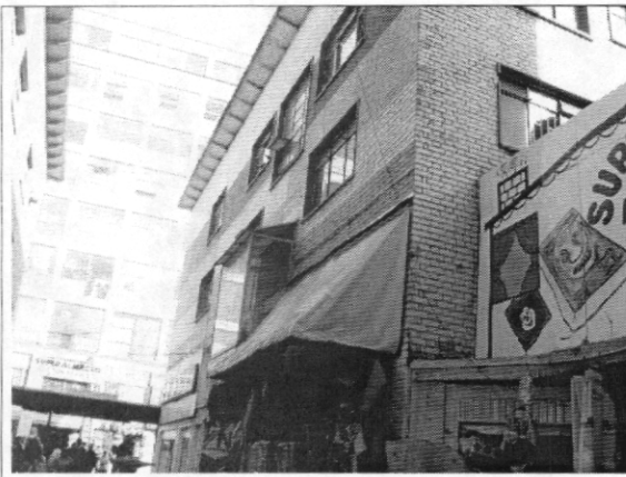
Foto 1. Muros externos de la edificación sin daño
