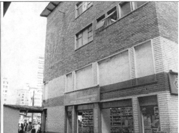
Foto 2. Muros de fachada al momento de la visita
