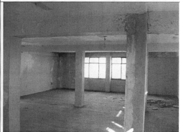
Foto 4. Aspecto general de los elementos estructurales
