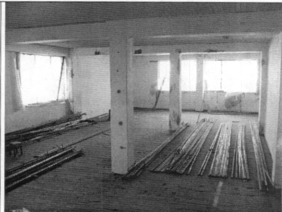
Foto 6. Los pisos superiores se mantienen deshabitados
