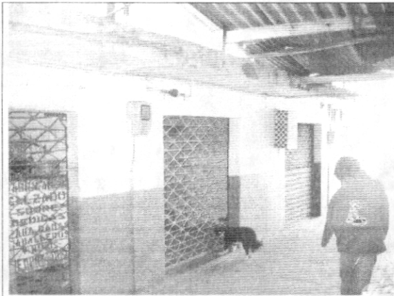
Foto 5. Puestos de los costados en mamposteria
