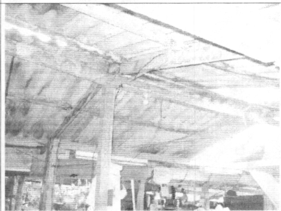
Foto 8. Vista general de la estructura de madera
