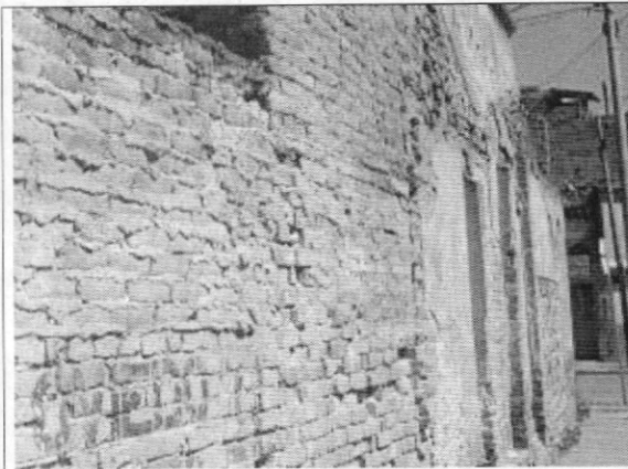
Foto 1. Muro de cerramiento, vista desde el exterior.
