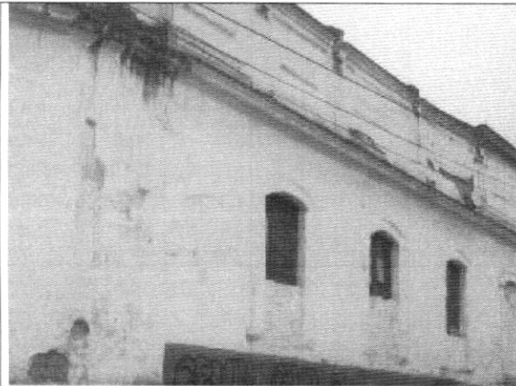
Foto 1. Muro fachada costado sur
