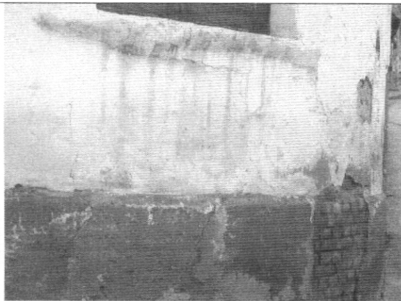
Foto 5. Parte superior muro sin elementos de confinamiento
