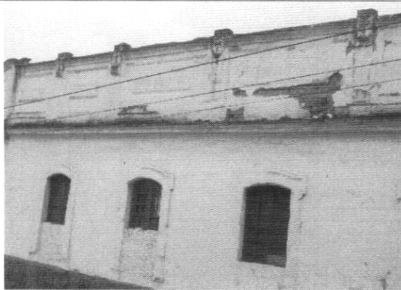
Foto 5. Parte superior muro sin elementos de confinamiento
