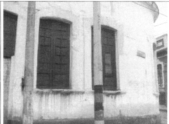
Foto 2. Muro fachada costado occidental
