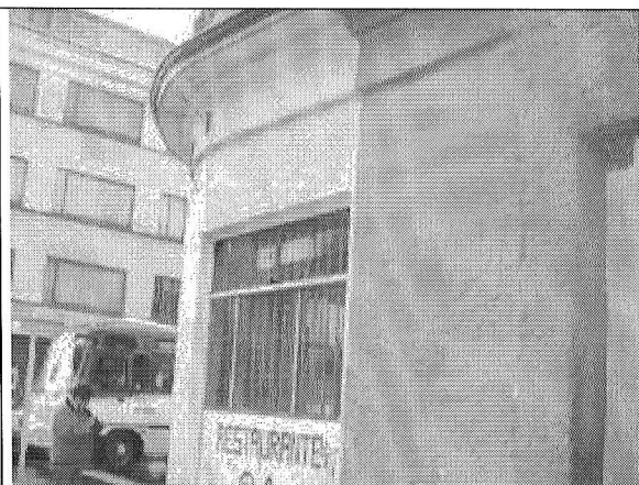
Foto 2. Muros de la edificación.
