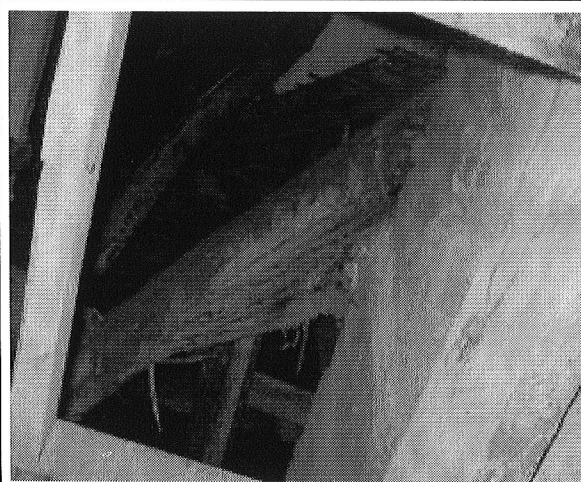
Foto 3. Viga principal de cubierta.
