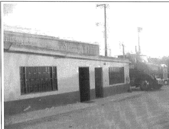
Foto 3. Construcción al interior del lote.
