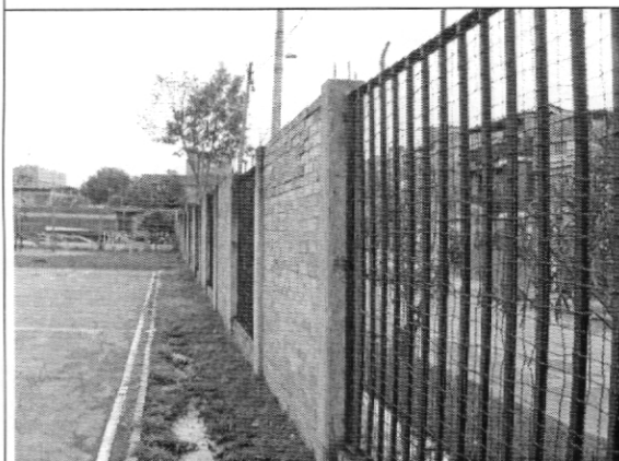
Foto 3. Vista interna del costado de la calle 25 sur
