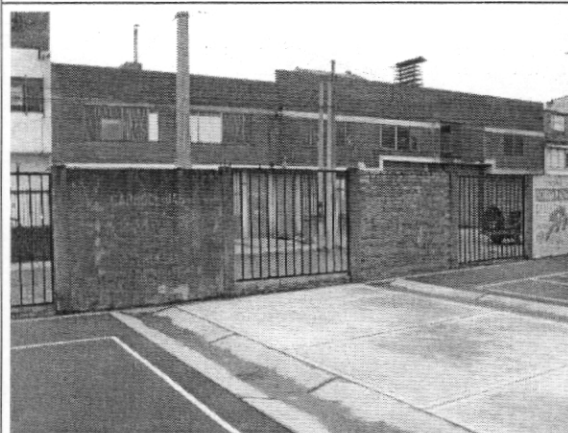
Foto 13. Vista interna del costado de la Carrera 69 C
