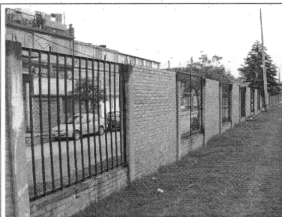
Foto 11. Vista interna del costado de la calle 24 A sur
