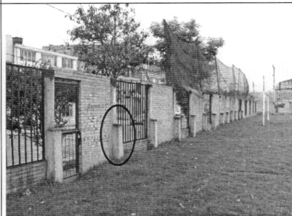
Foto 4. Costado Carrera 70 B, Trabajos para mejorar estabilidad
