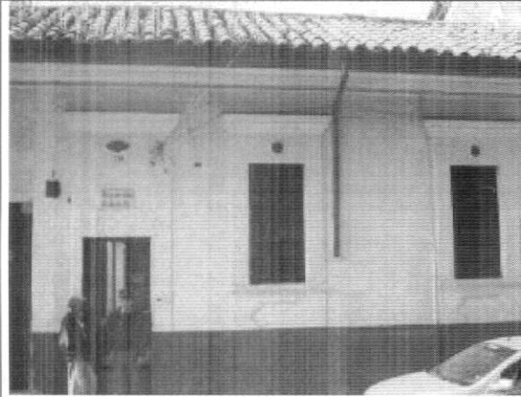
Foto 1. Vista general del inmueble.
