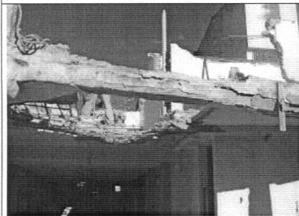
Foto 5. Placa de entrepiso.
