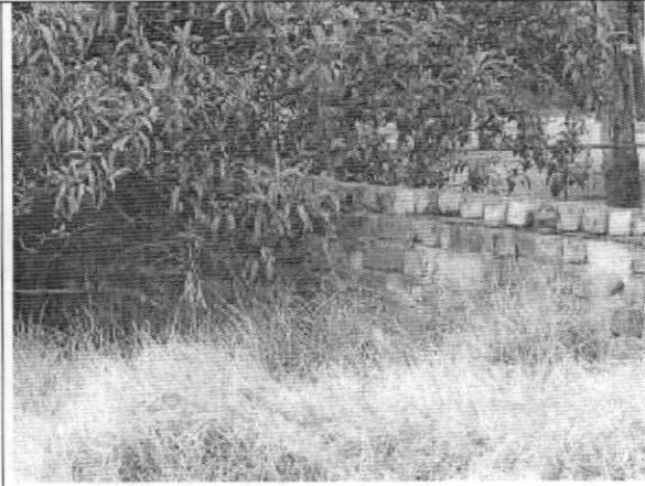
Foto 6. Relleno contra muro.
