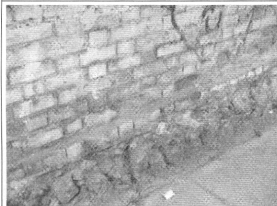
Foto 3. Cimentación en piedra.
