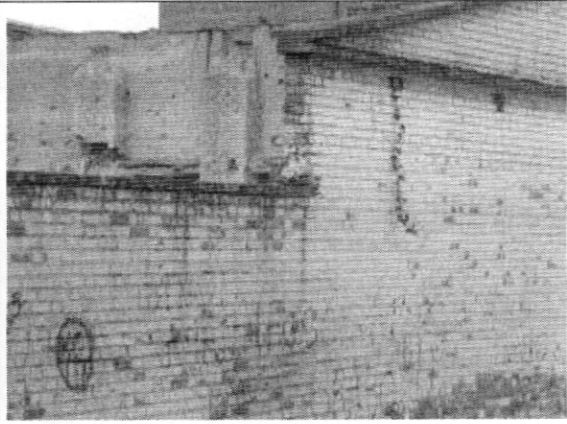
Foto 4. Sobrealtura sector occidental.
