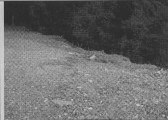
Foto 6. Escombros cercanos a parque infantil.
