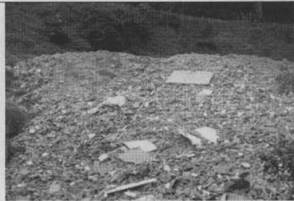
Foto 5. Colocación de escombros en talud aledaño
