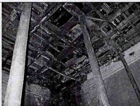
Foto 10. Detalle de los elementos de entrepiso.
