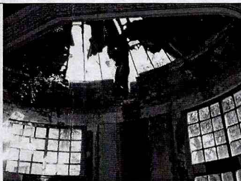
Foto 10. Detalle de los elementos de cubierta.
